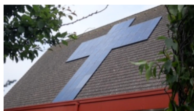
Kerkdak in Broek op Langedijk (NH)
