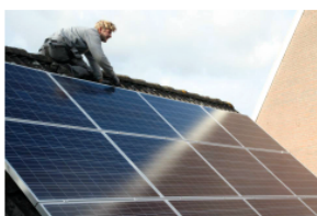
Voorbeeld kerkdak in Putten
